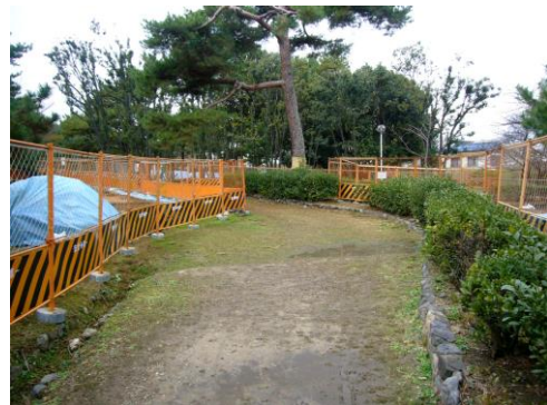
調査時の仮囲い状況（工事期間は搬入資材置場も含めて囲う必要あり）
