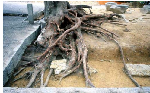
西塔基壇北東を侵すクスの根
